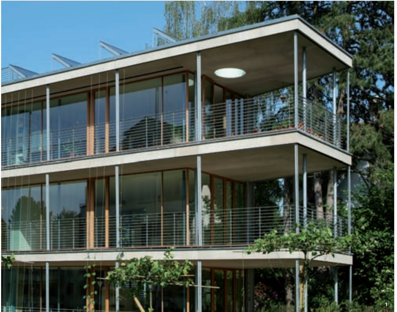
1: Teilansicht von Südwesten mit 18 m 2 Sonnenkollektoren auf dem Dach.
