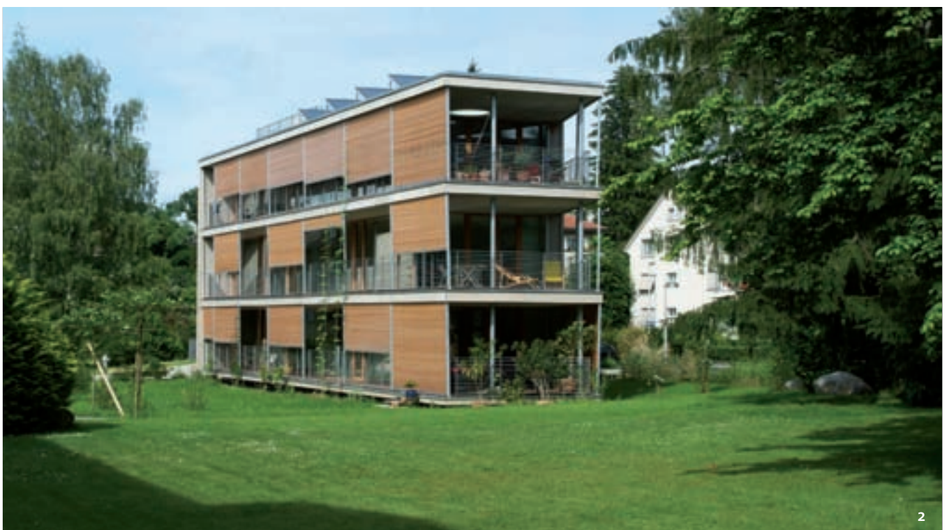
2: 3-Familienhaus Holzkonstruktion mit optimaler Wärmedämmung und teilweise heruntergelassenen Holzrolläden, als Sicht- und Sonnenschutz, auf der Westseite.
