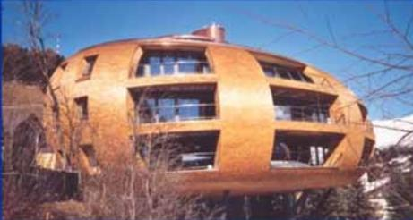
Die 2002 von Lord Norman Foster in St. Moritz gebaute Chesa Futura **reduziert** - vor allem dank der mit **50 cm gedämmten Gebäudehülle** - die **grossen Energieverluste** um 70 bis 95%.
