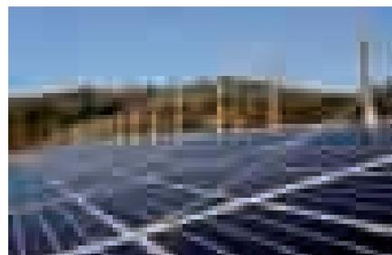
Sportanlage Gründenmoos in St. Gallen/SG: Die St. Galler Stadtwerke installierten auf dem Dach der Sportanlage eine Dünnschichtsolaranlage von 56 kWp. Diese produziert jährlich 42'000 kWh.
