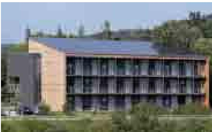
Abb. 1: Neubau Marché International, Bürogebäude mit optimal integrierter PV-Anlage, Kempthal/ZH. Diese PV-Anlage ist multifunktional: Sie dient als Dach zum Schutz gegen Regen, Schnee und Kälte und als Wärmedämmung; dazu erzeugt sie rund 40'000 kWh/a Solarstrom. Sie ist ganzflächig konzipiert, optimal und bündig in die Dachhaut integriert. Sie weist perfekte seitliche, first- und traufseitige Dachabschlüsse auf.
