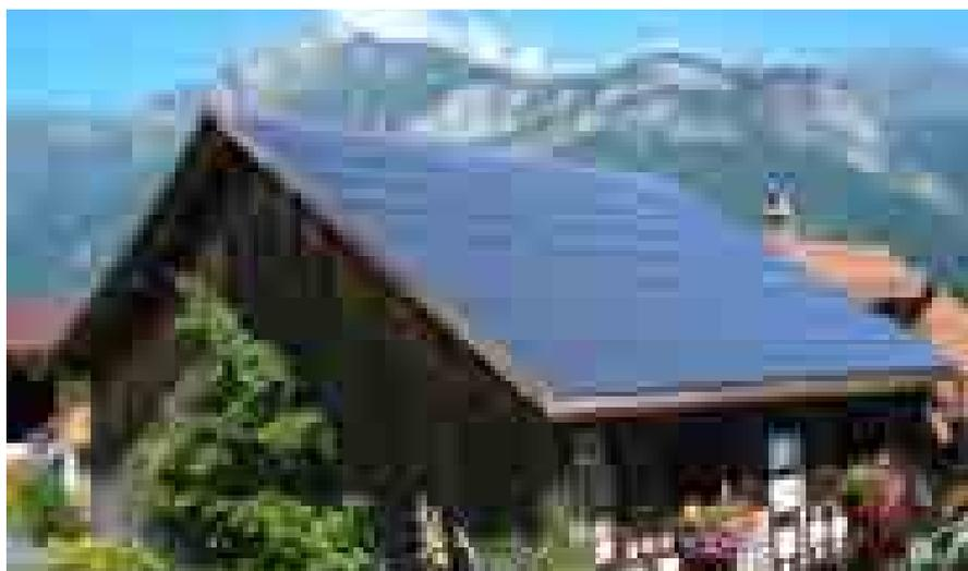
Abb. 2: Zeigt die vorbildlich in die Dachfläche im Sinne von Art. 18a RPG und Anhang 1.2 Ziff. 3.1 EnV integrierte Anlage. Die 9.5 kWp-PV-Anlage der Bauernfamilie Wildhaber in Flums ist multifunktional, vorbildlich vollflächig, dach-, first-, trauf- und seitenbündig optimal in die Dachhaut integriert.
