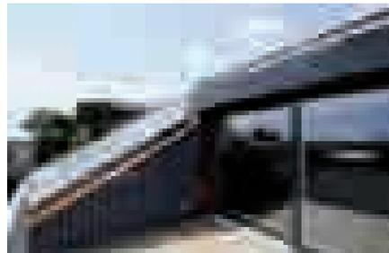
**Rénovation d'immeuble, Feldbergstrasse 4/6, Bâle (BS):** Tous les besoins en chaleur sont couverts par la bonne isolation thermique, par l'installation PV de 9,9 kWc et par les 34 m<sup>2</sup> de capteurs thermiques. La consommation d'énergie totale ultérieure a été réduite de 93%, passant à 15'800 kWh/a d'énergie tierce.
