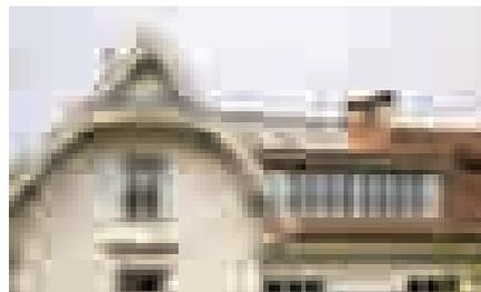
**Rénovation Minergie P, maison art nouveau, Arlesheim (BL):** La maison art nouveau construite en 1905 satisfait à la norme Minergie P grâce à son isolation thermique pouvant atteindre 30 cm, sa chaudière à bois de 4,2 kW et ses 10 m<sup>2</sup> de capteurs solaires thermiques.
