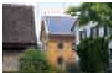
EFH Minergie-P Sanierung in Horgen: Das 1760 erbaute, EFH erreicht den Minergie-P Standard dank guter Wärmedämmung, 7.5 kWp-PV-Anlage und 5 m<sup>2</sup> Sonnenkollektoren den Minergie-P Standard. Es deckt somit etwa 70% des Gesamtenergiebedarfs.
