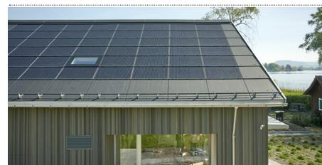
2 Die dachintegrierte 25 kW starke PV-Dachanlage harmonisiert mit dem schlichten Holzbau.
