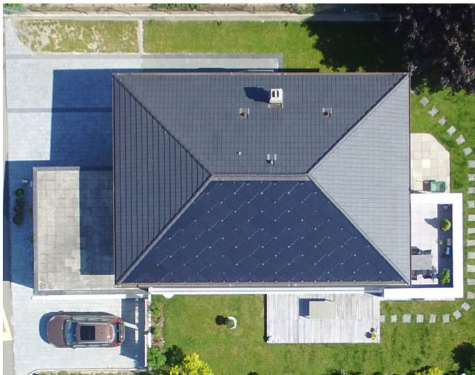
1 La nouvelle installation PV génère 11'500 kWh/a et couvre au moins 52% de la consommation.
