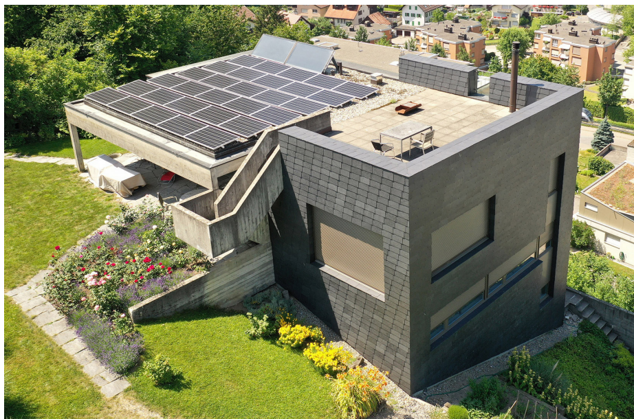
1 PV- und Solarthermie-Anlage produzieren 11'750 kWh/a und decken den Eigenenergiebedarf zu 114 %
