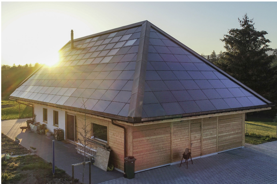
1 Das Strohballenhaus mit grosser Dachfläche produziert mit 30'181 kWh/a 74% mehr CO 2 -freie Solarenergie als es selbst benötigt.
