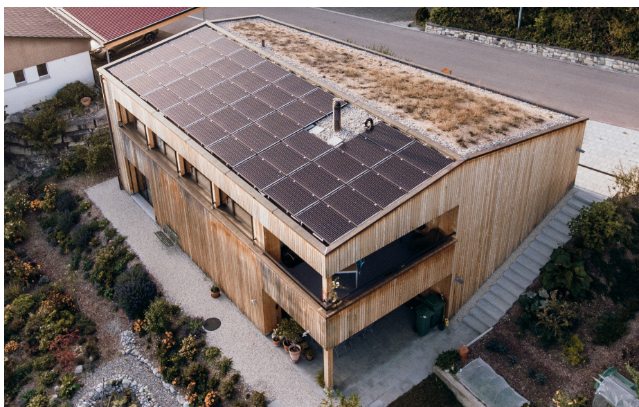
1 Die auf dem Süddach gut integrierte PV-Anlage produziert jährlich ca. 11'500 kWh oder 273%
