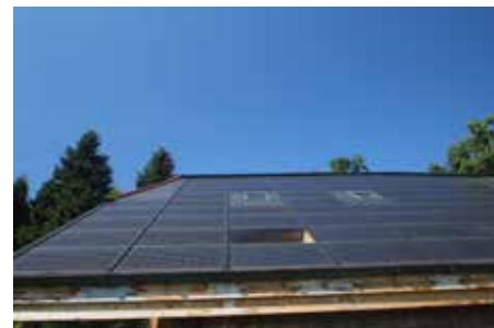
2 Auf der Südseite produziert die 15-kW-PV-Anlage mit ihren monokristallinen Zellen 16'800 kWh/a, harmonisch kombiniert mit der Sonnenkollektoranlage, die 12'200 kWh/a generiert.
