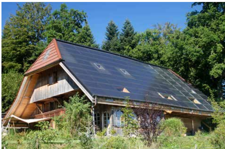
1 Das sanierte Bauernhaus in Madiswil/BE zeichnet sich durch die ansprechende, ganzflächig sehr gut integrierte Solaranlage aus. Sie deckt den Gesamtenergiebedarf zu 157%,
