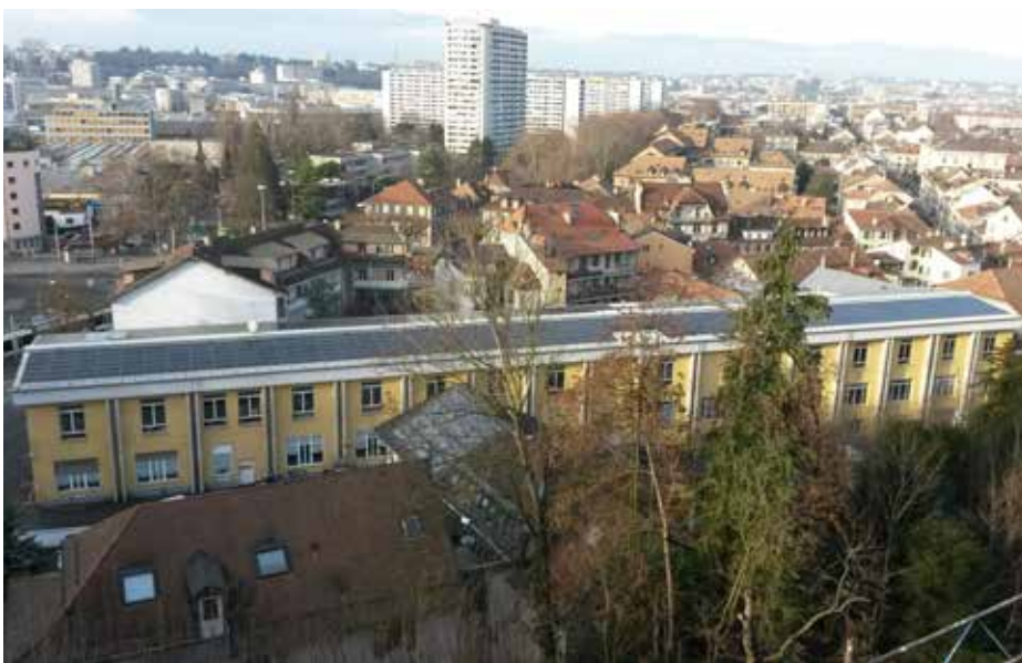
1 La communauté d'Emmaüs au cœur de Carouge (GE) et son installation PV de 178 kW, orientée est-ouest et produisant 161'700 kWh/a de courant solaire.
