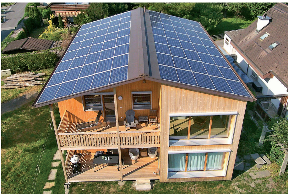
1 Das erweiterte, holzverkleidete und sanierte Zweifamilienhaus mit der dach-, seiten- und traufbündigen 19.6 kW starken PV-Anlage. Sie deckt 187% des Energiebedarfs.
