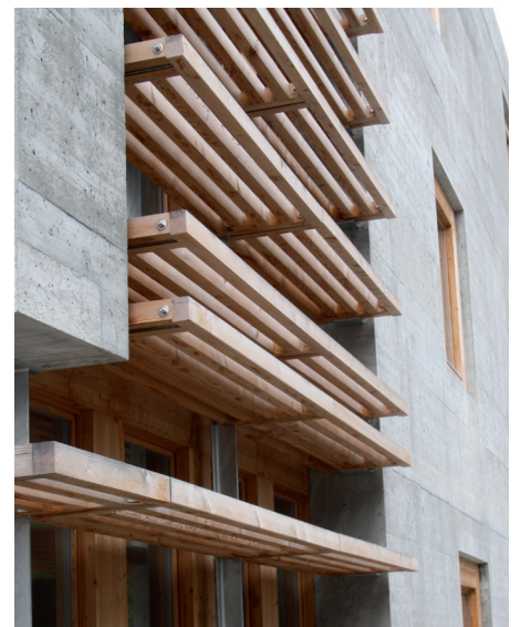
3 Lärchenlamellen nutzen im Winterhalbjahr die Solarenergie passiv und schützen im Sommerhalbjahr vor Hitze.
