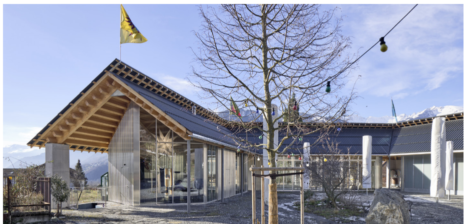
2 Das 68% Weingut überzeugt durch einen gelungenen Materialmix aus Holz, Stahl, Glas, Photovoltaik und Blech.
