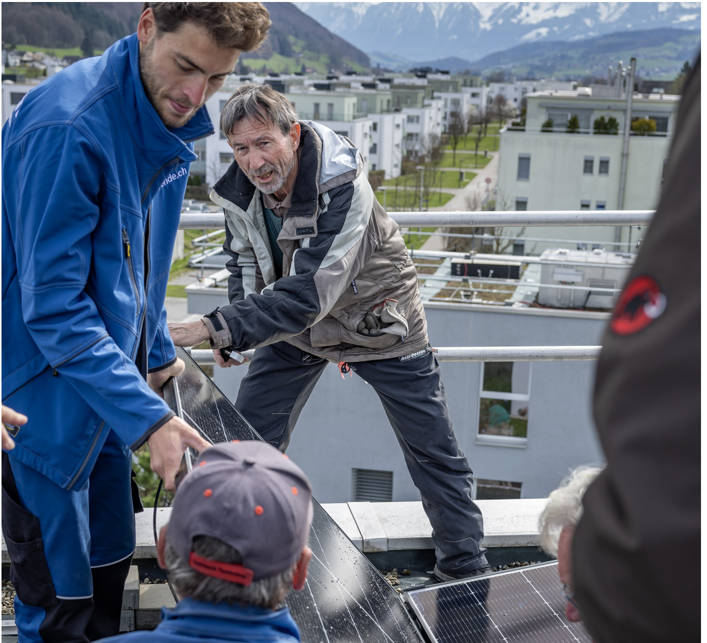
1/2 Mitarbeiter der Energiegenossenschaft arbeiten zusammen mit Privatpersonen an der Installation von Solaranlagen.
