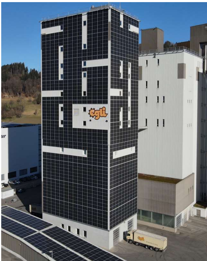
1 Die Fassaden-installierten PV-Anlagen weisen insgesamt eine Leistung von 696 kWp auf.
