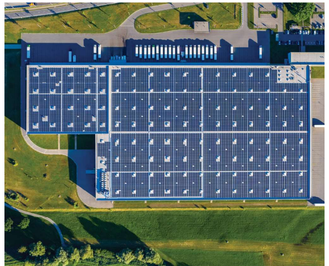
2 Ansicht von oben des ALDI Verteilzentrum in Perlen. Die installierte Leistung von 6'425 kWp generiert jährlich rund 7.33 GWh; mit dem Solarstromüberschuss von 4.18 GWh können 3'000 E-Autos jährlich je 10'000 km fahren; mit dem gesamten Solarstrom rund 5'250 E-Autos.
