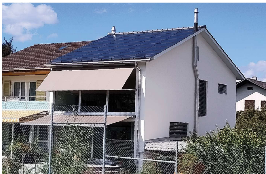
1 Die perfekt integrierte 7 kW starke PV-Anlage auf der Südseite des Satteldachs erzeugt jährlich rund 6'400 kWh Solarstrom.
