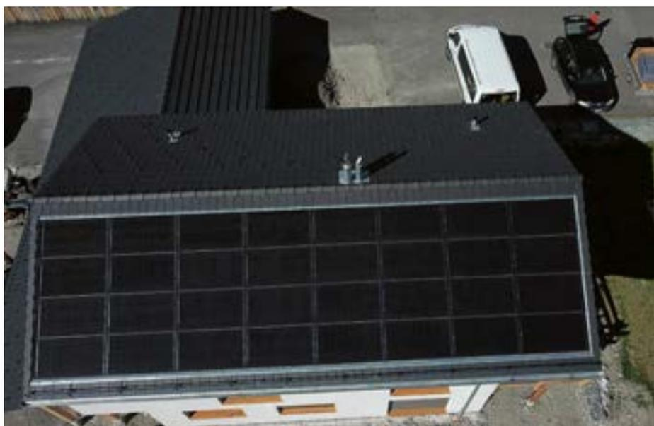
1 L'installation PV génère 9'800 kWh/a, ce qui assure au bâtiment une autoproduction de 285%.
