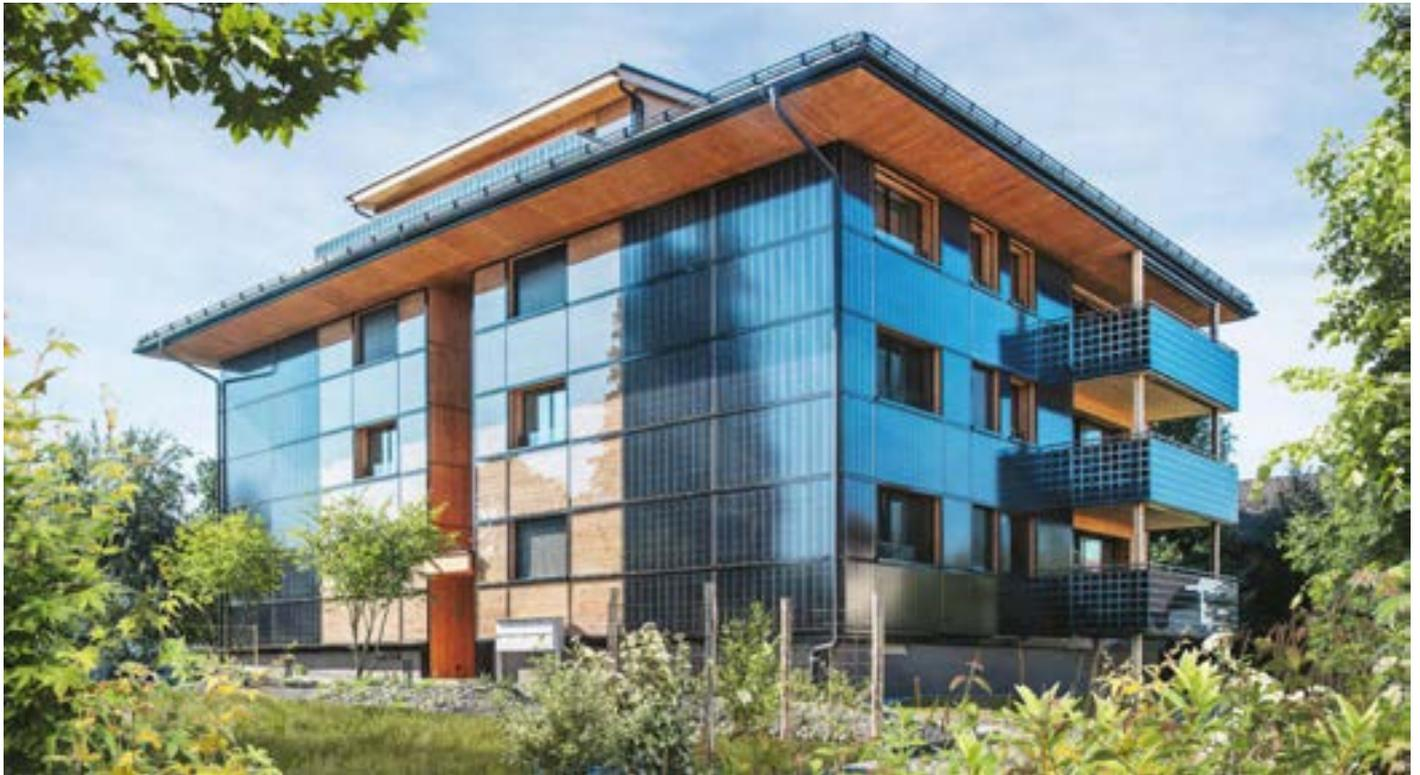
1 Das 315% NF Min.P/PlusEnergie-MFH produziert jährlich 78'000 kWh Solarstrom statt 137'700 kWh/a statt fossil-nukleare Energien zu verbrennen.
