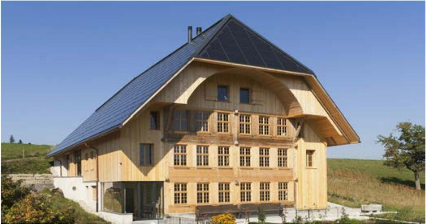
**Das 2015 sanierte 700% PEB-Doppelfamilienhaus Anliker von 1765 reduzierte 93.4% E-Verluste, deckt 100% des Gesamtenergiebedarfs; erzeugt gemäss EW-Messungen 2016-2019 dazu 77'500 kWh/a CO2-freien Solarstrom. Damit können 55 Elektroautos jährlich 12'000 km emissionsfrei fahren.**
