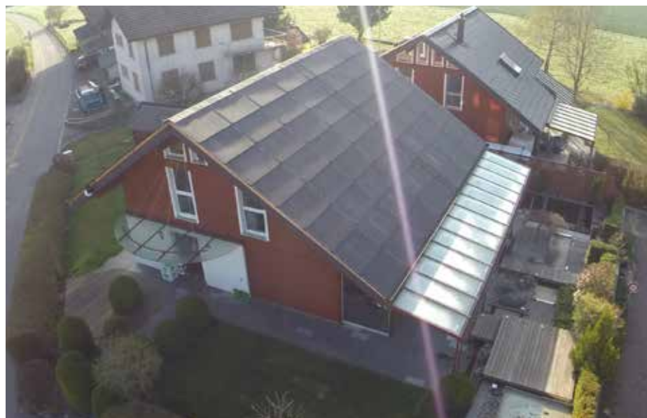
1 Die 25 kW starke und optimal dachintegrierte PV-Anlage deckt den Gesamtenergiebedarf des PEB-EFH von rund 11'800 kWh/a.
