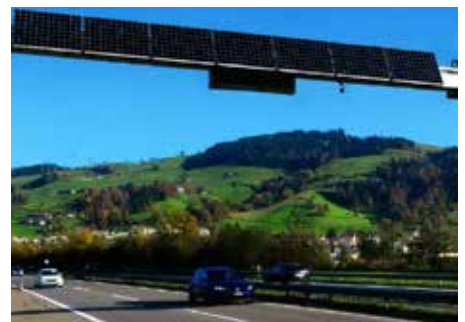
1 Solare Verkehrsregelung der Autobahn A14 zwischen Rotkreuz und Buchain, Ziff. 12.
