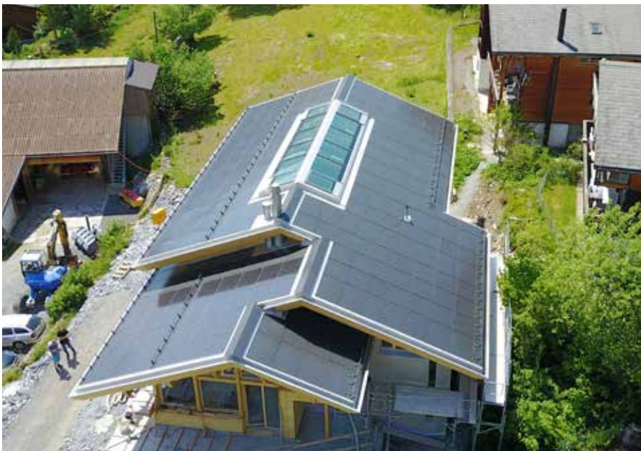
1 Die auf dem Süddach errichtete 14.7 kW starke PV-Anlage produziert rund 15'700 kWh/a.
