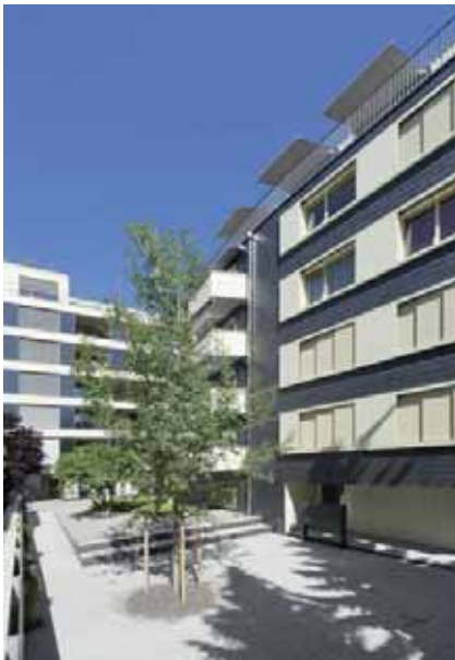
1 In die Hoffassade des MFH an der Mühlebachstrasse sind 95 m 2 Flachkollektoren ästhetisch vorbildlich vertikal in die Süd- und Westfassade integriert. Zusammen mit der PV-Anlage auf dem Dach erzeugen sie 39'763 kWh pro Jahr.
