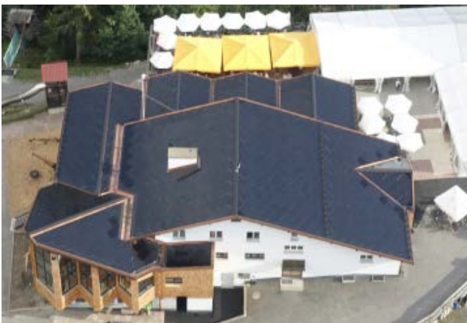
1 Die perfekt integrierte und ästhetisch ansprechende 97 kW starke Solaranlage fügt sich gut in das Landschaftsschutzgebiet ein.
