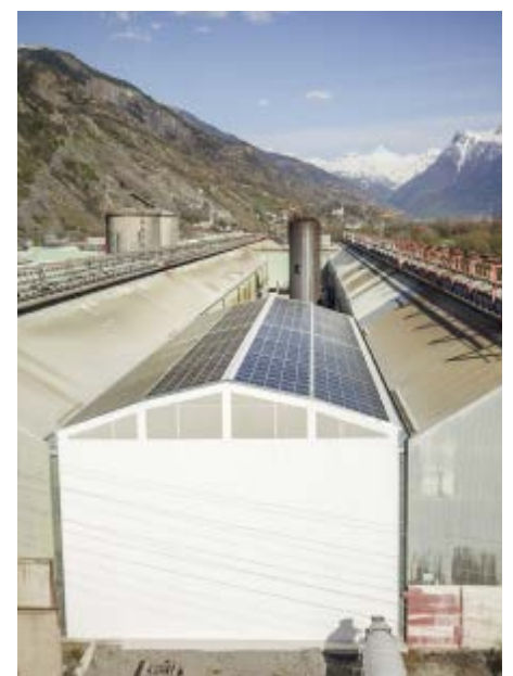
2 Die 277 kW starke PV-Anlage wurde auf einem Membrandach installiert.
