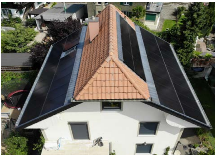
1 Die nicht ganzflächig integrierten PV- und solarthermischen Anlagen produzieren jährlich 15'800 kWh und decken 166% des Eigenenergiebedarfs des EFH Schneider in Steffisburg.
