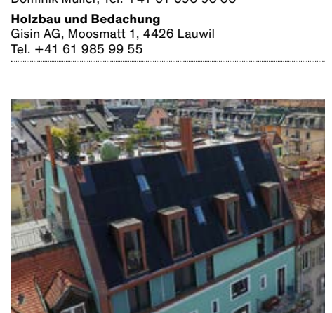
3 Das aufgestockte MFH mit 12 Wohnungen und der ganzflächig integrierten 13.9 kW PV-Anlage emittiert immer noch ca. 24.5 t CO 2 -Emissionen.
