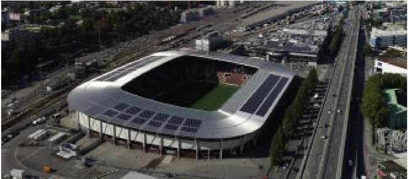
1 Stade de Genève 2021 Solarstrom PV: 942 kWc \approx 0.95 GWh/a ; émet encore 600 t CO 2 par an
