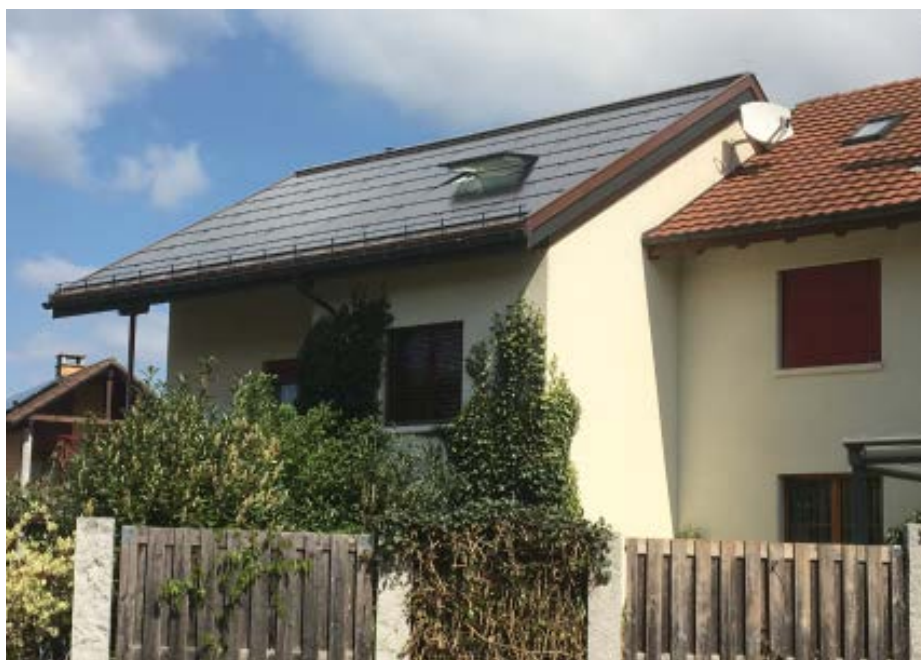
1 Das EFH Wehrli mit dem gedämmten Dach und der ganzflächig integrierten PV-Anlage.
