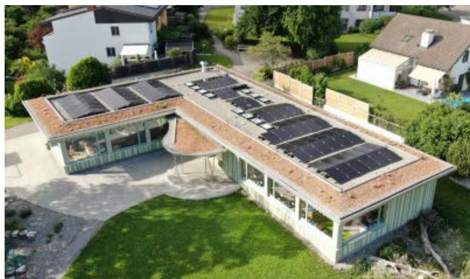
1 Der PlusEnergie-Kindergarten Neubau in Mettmenstetten erzeugt mit der 29.76 kW starken PV-Dachanlage 29'400 kWh/a und sorgt für eine Eigenenergieversorgung des Kindergartens von 311%.
