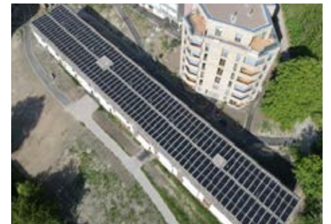
3 Die 114 kW starke PV-Dachanlage erzeugt 125'000 kWh/a.
