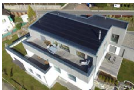
L'élégant immeuble en bois est doté d'une installation solaire de 13 kWc sur tout le toit. Avec 14'600 kWh/a, les modules PV assurent une autoproduction de 115%.
