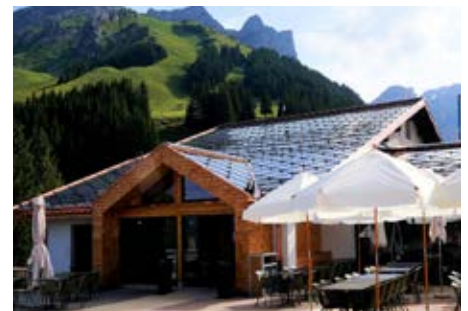
2 Die 97 kW starke Solaranlage produziert jährlich 73'500 kWh.
