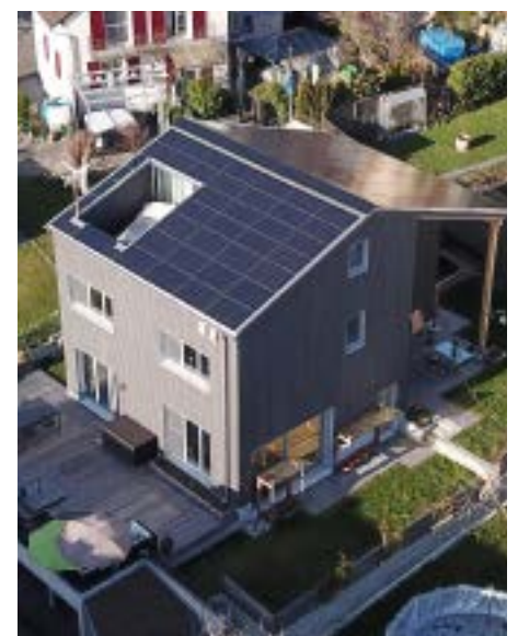
2 Das Haus verfügt über eine Eigenenergieversorgung von 374%. Der Solarstromüberschuss wird an Nachbarhäuser weitergegeben.
