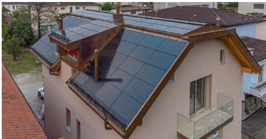
Das sanierte Einfamilienhaus der Familie Bianda in Losone mit der ganzflächig integrierten PV-Dachanlage.
