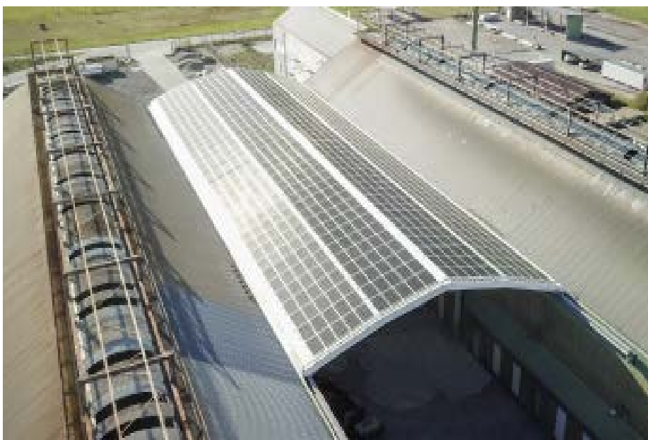
1 Die perfekt integrierte PV-Anlage auf dem Dach der Theler AG produziert jährlich 262'600 kWh.
