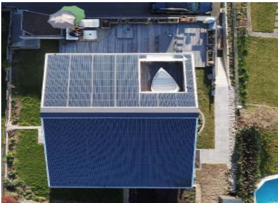
1 Die vorbildlich integrierte 15 kW starke PV-Anlage auf dem Dach produziert 14'300 kWh/a.
