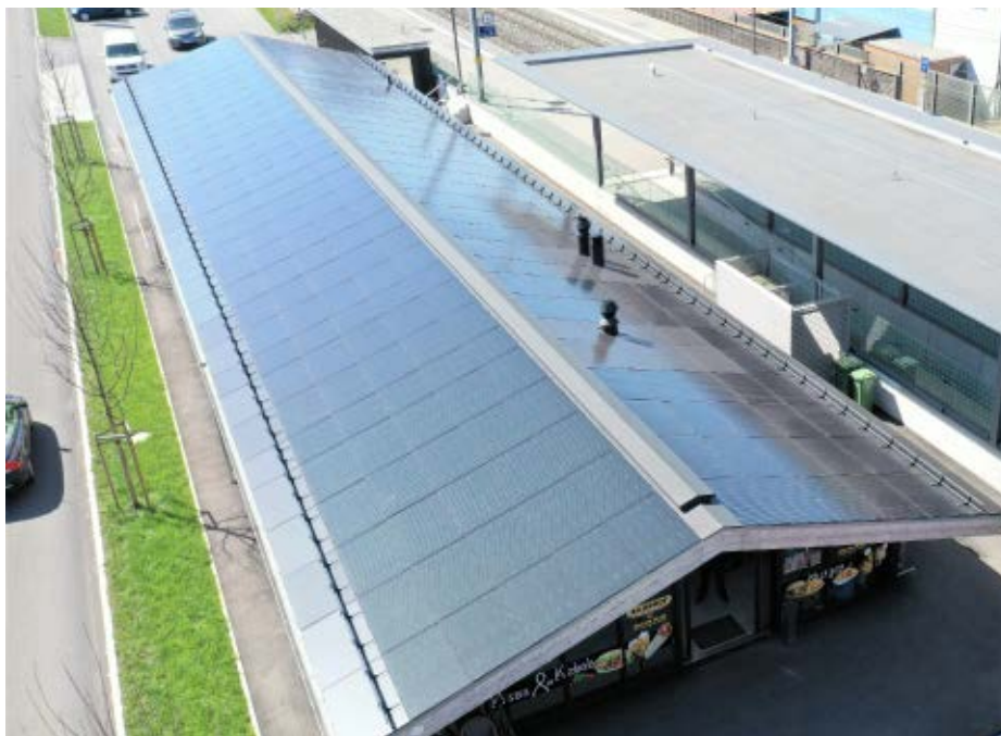
1 Die vollflächig integrierte PV-Anlage erzeugt 53'300 kWh/a.
