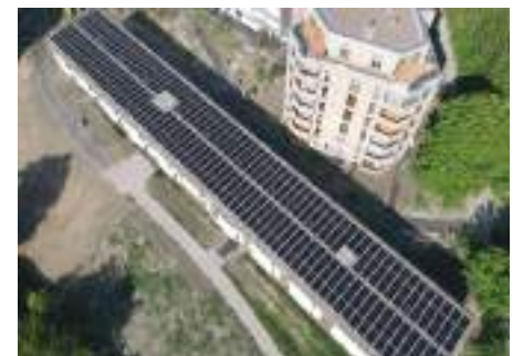
3 Die 114 kW starke PV-Dachanlage erzeugt 125'000 kWh/a.
