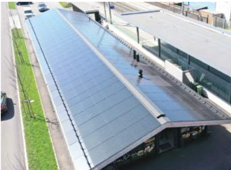
1 Die vollflächig integrierte PV-Anlage erzeugt 53'300 kWh/a.
