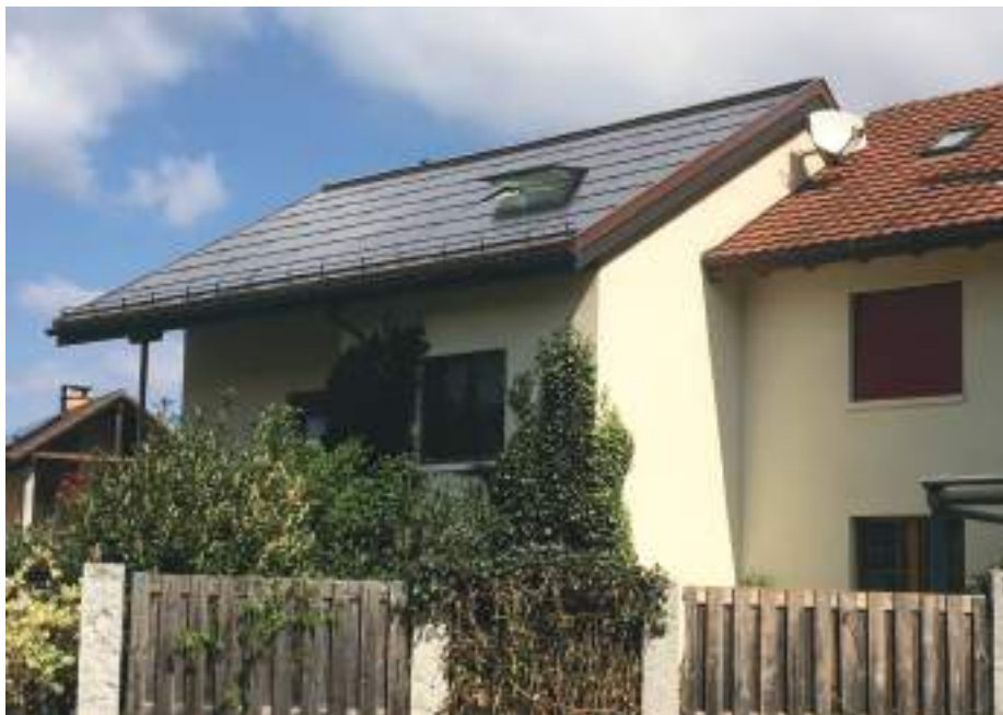
1 Das EFH Wehrli mit dem gedämmten Dach und der ganzflächig integrierten PV-Anlage.
