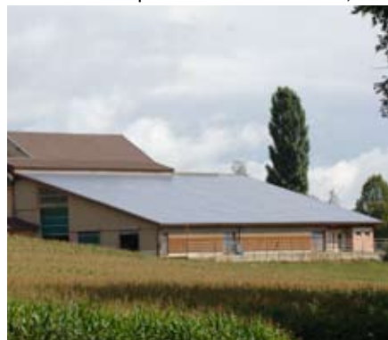
110 kWp-PV-Anlage in Barbarèche
