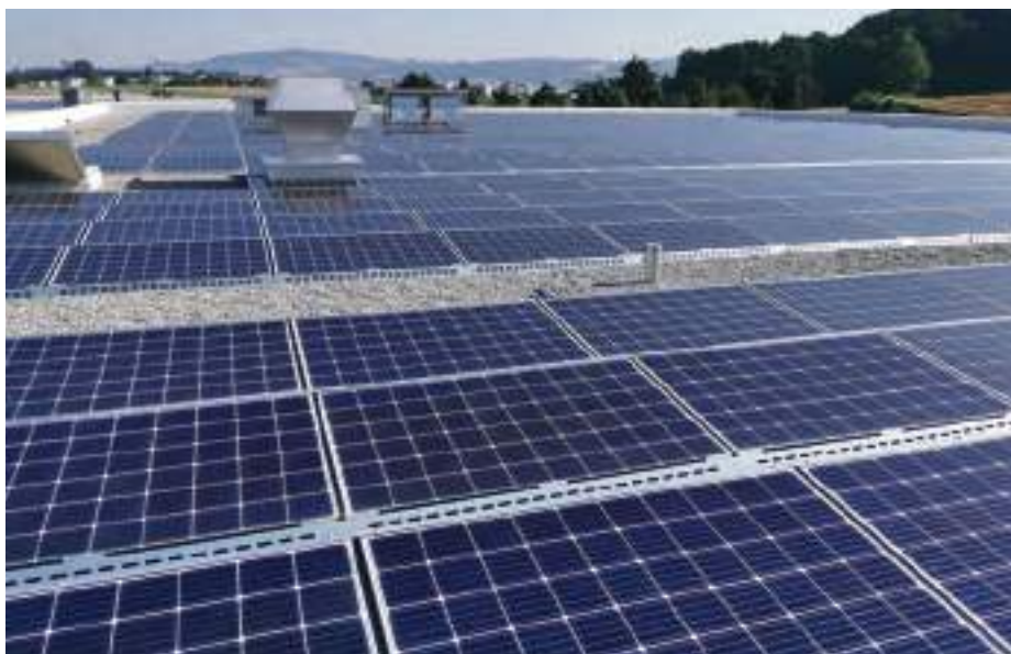
1 Die 810 kW starke PV-Anlage auf dem Dach der Neubauten produziert 0.58 GWh/a
