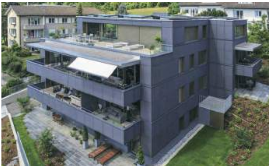
1 Süd-Ansicht Mehrfamilienhaus Oeschger. Die ganzflächig integrierte Fassadenanlage produziert rund 23'500 kWh/a.
