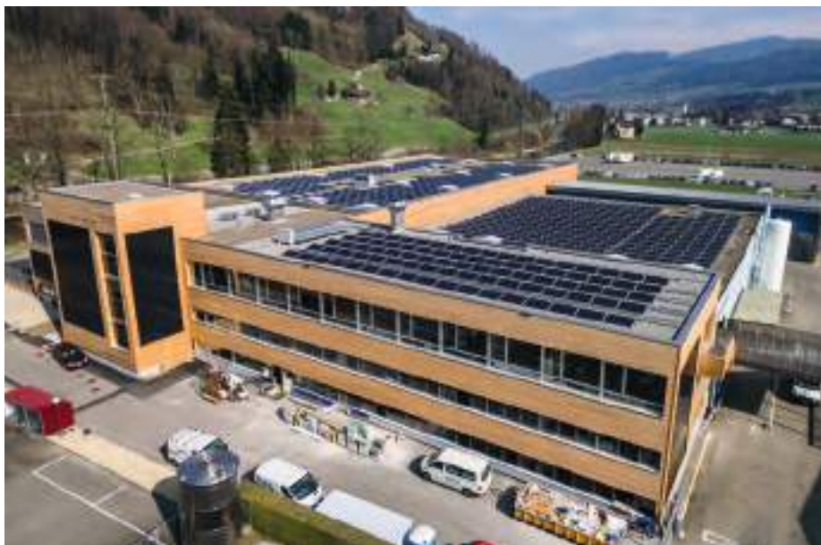
1 Am erweiterten Produktions- und Innovationsstandort der SIGA in Werthenstein/LU produzieren die Dach- und Fassaden-PV-Anlagen 379'220 kWh/a
