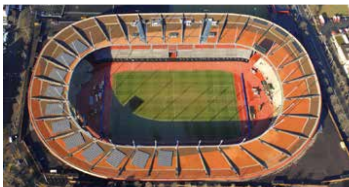
5 Stadion Letzigrund, Zürich, Schweiz: Die 0.23-MWp-Solaranlage ist schlecht bzw. überhaupt nicht integriert und erzeugt bloss ca.10% der vorbildlich integrierten 2.1 MW starken Solaranlage in Biel (vgl. S. 20).
