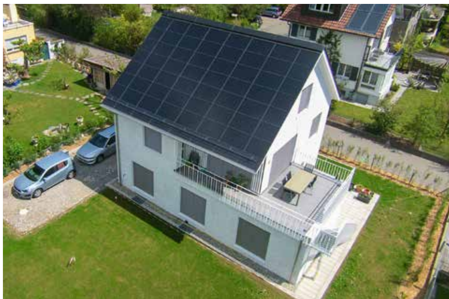
1 Südansicht des Neubaus. Der Gesamtenergiebedarf des PlusEnergiebaus liegt bei rund 9'250 kWh/a, der Solarstromüberschuss bei 8'330 kWh/a.
