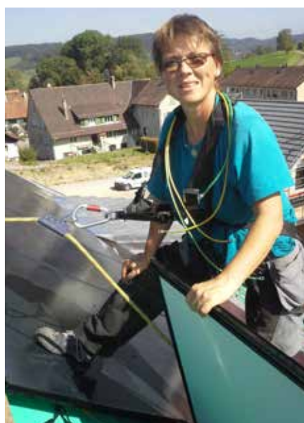
2 Eva Leutenegger montiert, gut gesichert, PV-Paneele auf einem Dach.
