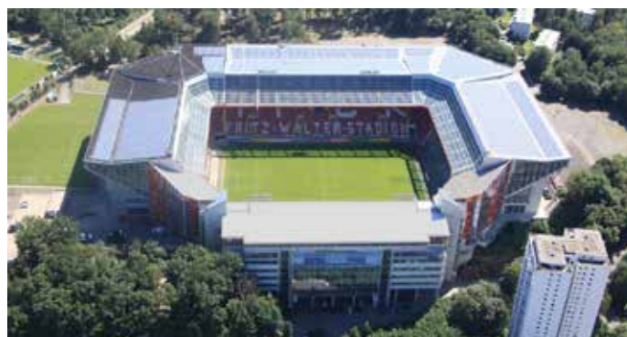
2 Fritz-Walter-Stadion, Kaiserslautern, Deutschland: Das 1920 errichtete Stadion wurde 2005 saniert und mit einer 1.35 MW starken PV-Anlage ausgestattet. Es erzeugt jährlich 1.2 Mio. kWh Solarstrom.
