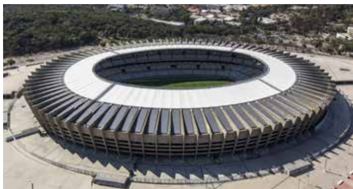
1 Estádio Mineirão, Belo Horizonte, Brasilien: Das 1965 gebaute Stadion wurde bei der Sanierung 2010 mit einer 1.4 MW starken PV-Anlage ausgestattet.
