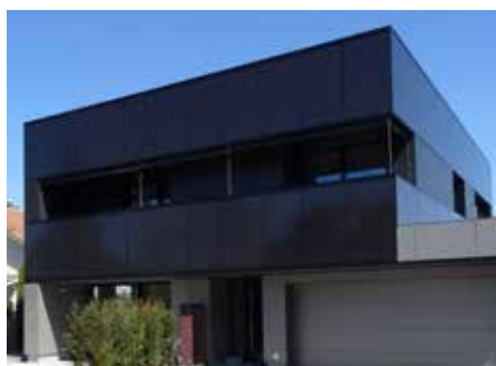
3 208%-PEB-EFH Güller, Würenlos/AG: Solarstromproduktion von morgens bis abends mit hohem Eigenverbrauch (112.5 kWh/m 2 a).
