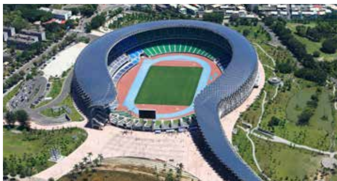
3 National Stadium Kaohsiung, Kaohsiung, Taiwan: Die perfekt integrierte, 1.02 MW starke PV-Anlage vermittelt dem schlangenförmigen Stadium seine charakteristische Form und Farbe.
