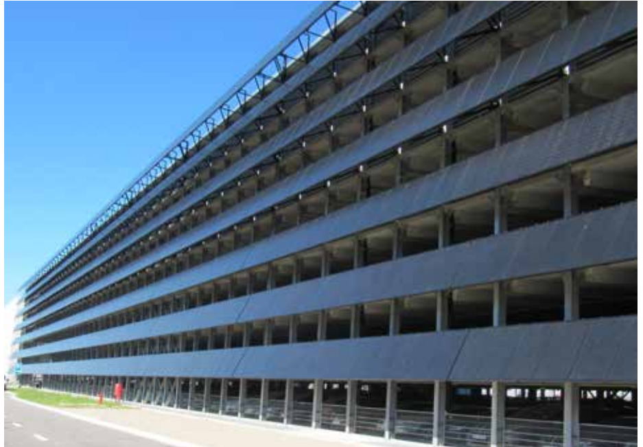
2 Solare Fassade, Hoffman-La Roche, Kaiseraugst/AG mit 334'000 kWh/a (140 kWh/m 2 a)
