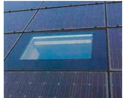
1 Die auf beiden Dachflächen perfekt installierte PV-Anlage von 116 m<sup>2</sup> erzeugt jährlich 18'700 kWh und damit 165% mehr Energie, als der Haushalt benötigt.
