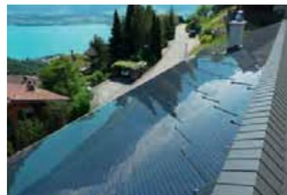
2 Das Solarschindeldach des PEB-EFH. Die vollflächige, südseitig integrierte 17.5-kWp-Dachanlage liefert 18'400 kWh/a.
