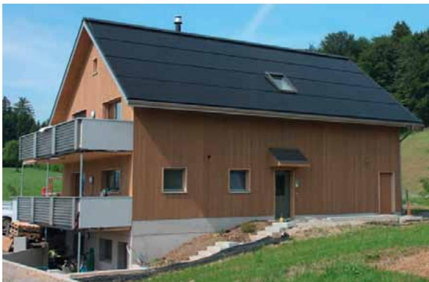
1 Vorbildlich seiten-, fi st- und traufbündig ganzflächig ist die PV-Dachanlage integriert. Die Solarthermie-Vakuurröhren-Anlage an den Balkon-Brüstungen und die PV-Anlage generieren jährlich 28'900 kWh Energie.
