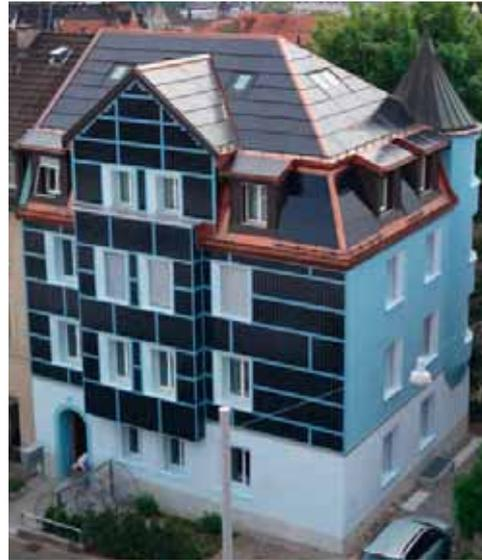
2 Nordostansicht der ersten Jugendstil-MFH-Sanierung in Europa dank Min.-P-Dämmung und Solarnutzung. Der Energiebedarf sank um 88% von 130'000 kWh auf 16'400 kWh/a. Zugleich erzeugt das PEB 19'400 kWh/a Solarenergie.
