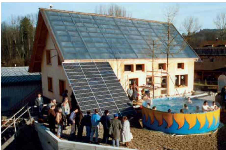
1 Das Solarhaus Jenni am 31. Jan. 1990 bei einer solaren Badeveranstaltung mit 37°C warmem Wasser. Die 5.6 kW starke PV-Anlage und die 84 m 2 Sonnenkollektoren garantieren eine Eigenenergieversorgung von über 100%.
