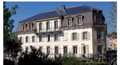
L'installation PV de l'Hôtel des Associations s'intègre parfaitement à toute la surface de la toiture et préserve en outre le caractère historique du bâtiment.
