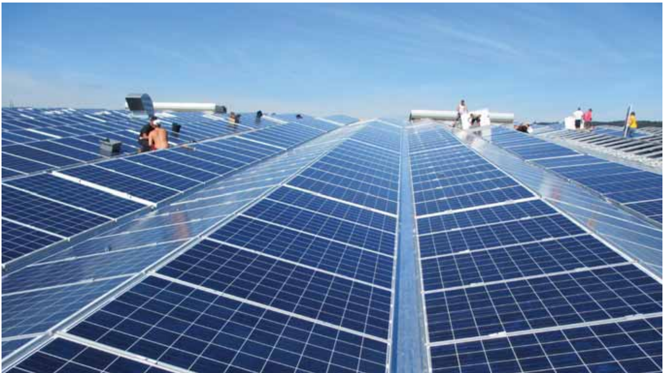
1 Die 2.9 MWp-Photovoltaikanlage liefert jährlich 2.5 Mio. kWh und deckt ungefähr 7% des Strombedarfs aller 15'150 Einwohner/innen der Stadt Wohlen.
