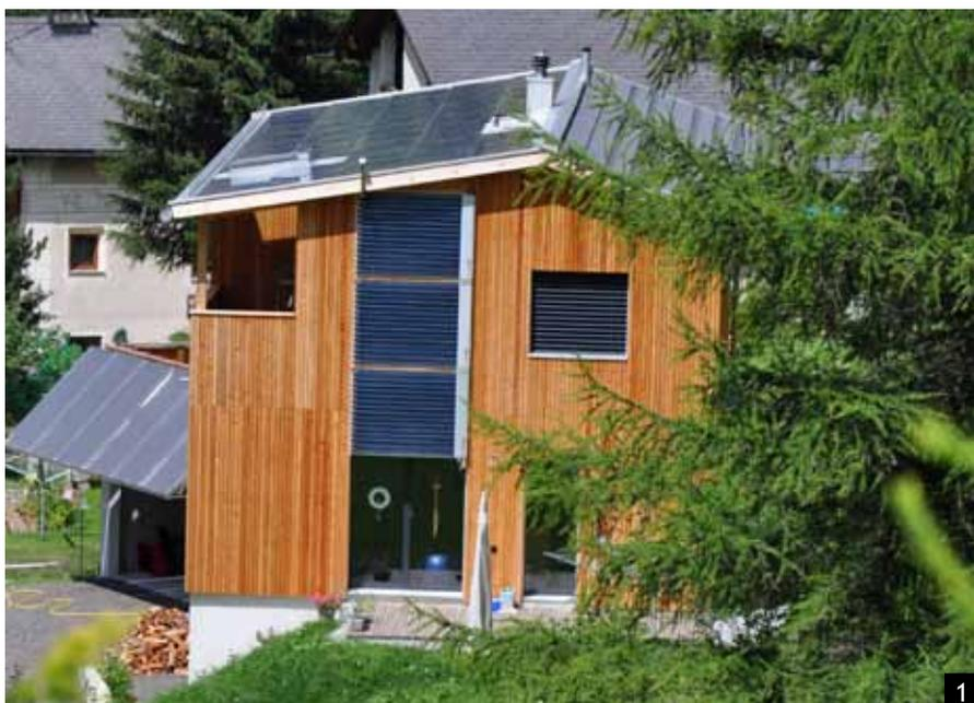
1: Das Sonnenlicht wird durch passive Nutzung, thermische Kollektoren und eine PV-Dachanlage optimal ausgenutzt.
