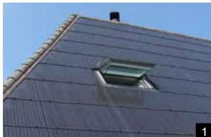
1: Die optimal integrierte PV-Anlage in Uettligen/BE "erntet" jährlich 182 kWh pro m<sup>2</sup> Dachfläche für das sanierte Bauernhaus von 1819.
