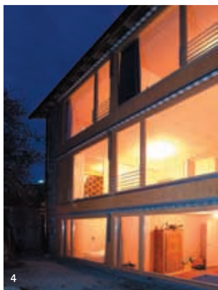
4: Grosse Südfenster dienen der passiven Solarnutzung (Maison Fournier, St-Léonard).
