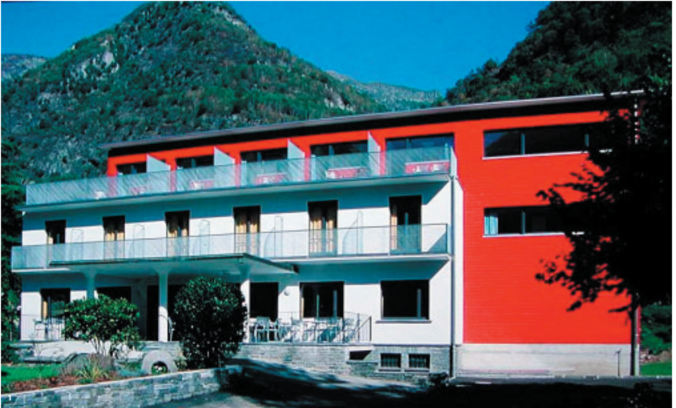
1: L'Eco-Hotel Cristallina 2: I moduli fotovoltaici e i collettori solari sul tetto 3: Il silo del cippato per il riscaldamento
