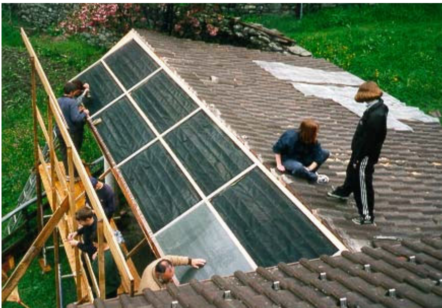
Jugendliche montieren Sonnenkollektoren in Cauco (TI)
