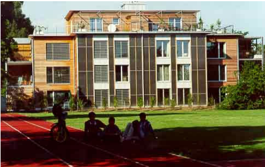
Bild links: Südwestansicht des MFH Rychenbergstrasse in Winterthur
