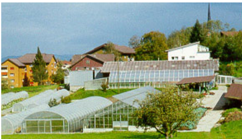
Biohof Widacher, Malters mit dem optimal integrierten Sonnenkollektorfeld 32 m 2
