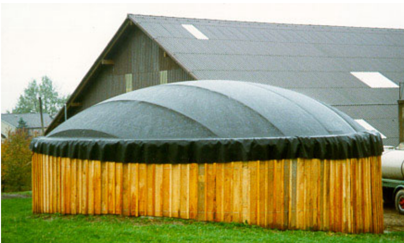
Kompakt-Biogasanlage, Familie G. + J. Schmid, Goldach
